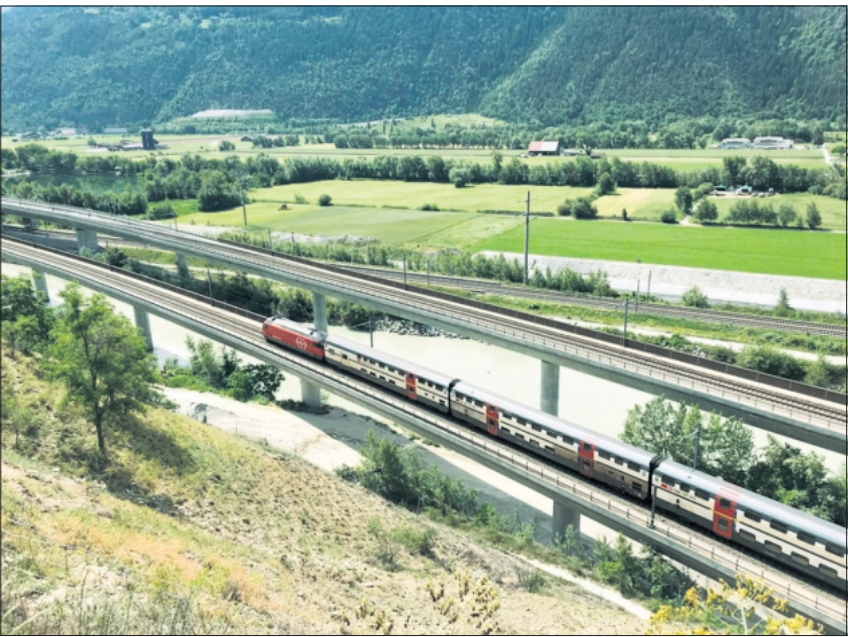
Das Tunnelportal Lötschbergbasistunnel in Raron. [Bild SAB]
