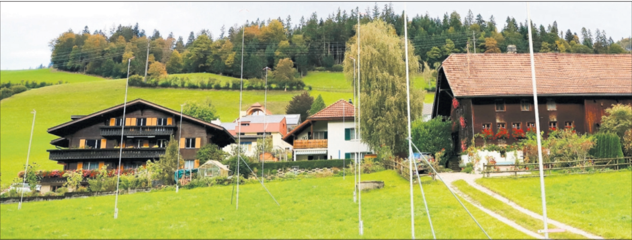
Die aufgestellten Bauprofile zeigen die Dimensionen des geplanten Bauprojekts auf dem Grundstück Chräigade in Schüpfheim. [Archivbild Bruno Rösli]
